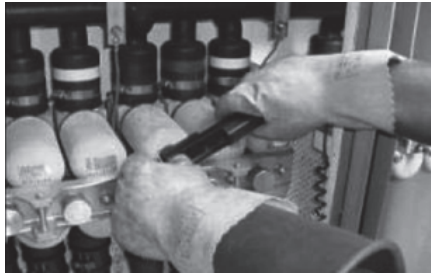
写真2 現場でのAE測定状況例 10)
