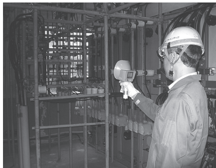
写真4 コロナ放電チェッカー「MK-720」使用状況例 Photo 4 Typical measurement situation using corona discharge checker "MK-720"
